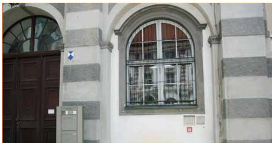
Abb. 8: Brandmeldeanlage in einem Kloster: Feuerwehrschlüsseldepot, Druckknopfmelder, Rauchmelder (Zisterzienserinnenabtei Waldsassen, Oberpfalz)
