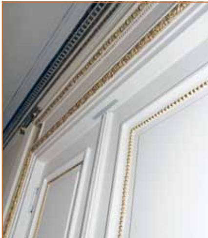
Abb. 5: T 90-Tür aus Holzwerkstoffen mit integrierter Feststellanlage zur Unterteilung einer Klosteranlage (Kloster Triefenstein)
