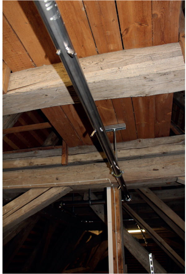
2. Eichstätt, Dom, Wassernebel-Löschanlage auf dem Dachboden, Wasserleitung mit Löschdüsen, 2025
